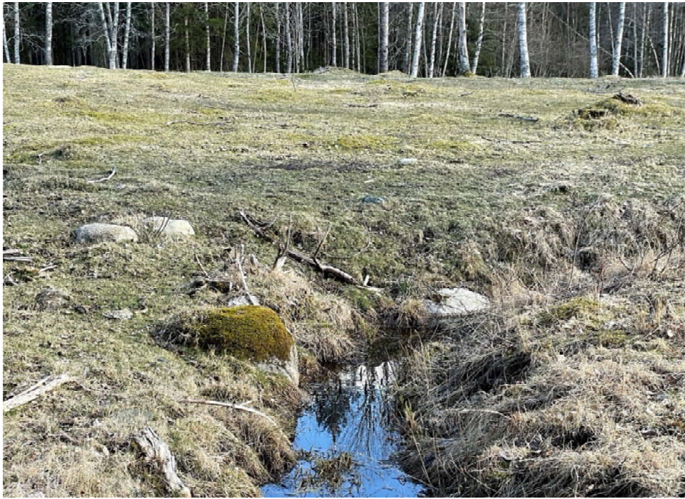
Foto 10. Ett äldre dike har här fått en vinklad fåra. Fyra – fem större sterner kompletterar i vinkeln.
